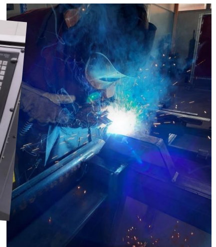
Abschweißen eines Containers
